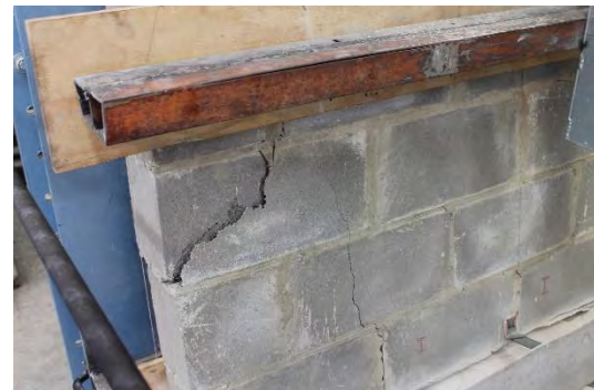
Foto 2. Aplastamiento en la mampostería.
