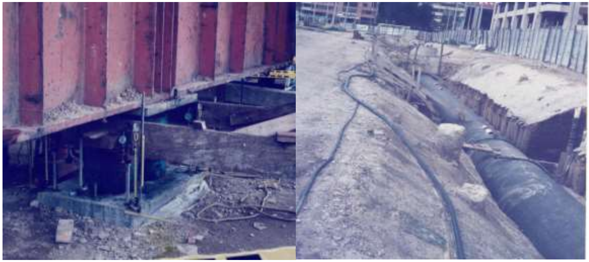
Figura 6. Fotos del ensayo de carga (izquierda) y del tubo destapado para construcción de sillines (derecha)
