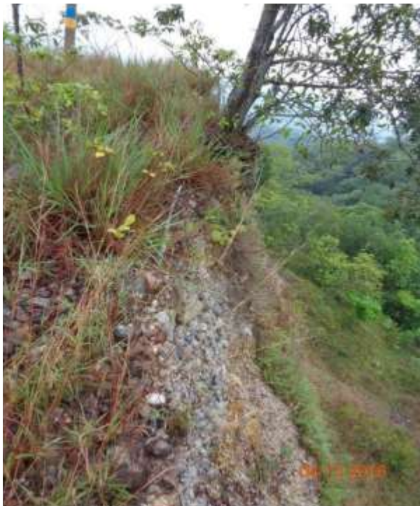
Figura 4. Talud en el DV del ducto.
