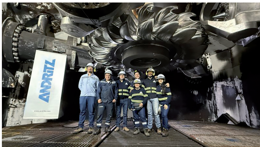
Figura 1. Repotenciación hecha por Andritz. Central hidroeléctrica del Guavio, 2025.
